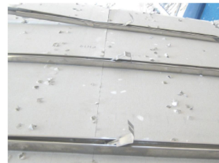
(c) クリップの変形
